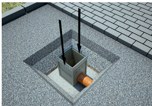
2. Hofeinlauf auf Betonbett setzen. Rohrleitung anschließen. Bei Anschluss eines Regenfallrohres, die Vorformung am Aufsatzkasten öffnen und Rohrstutzen einsetzen.
