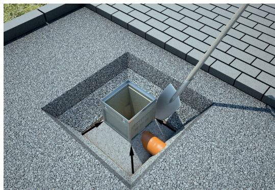
3. Hofeinlauf waagrecht ausrichten. Betonbett auffüllen und an den Flanken des Einlaufkastens hochführen.
