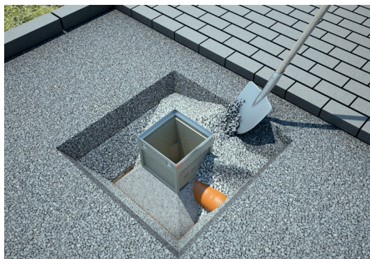
4. Grube mit Schotter auffüllen und sorgfältig verdichten.
