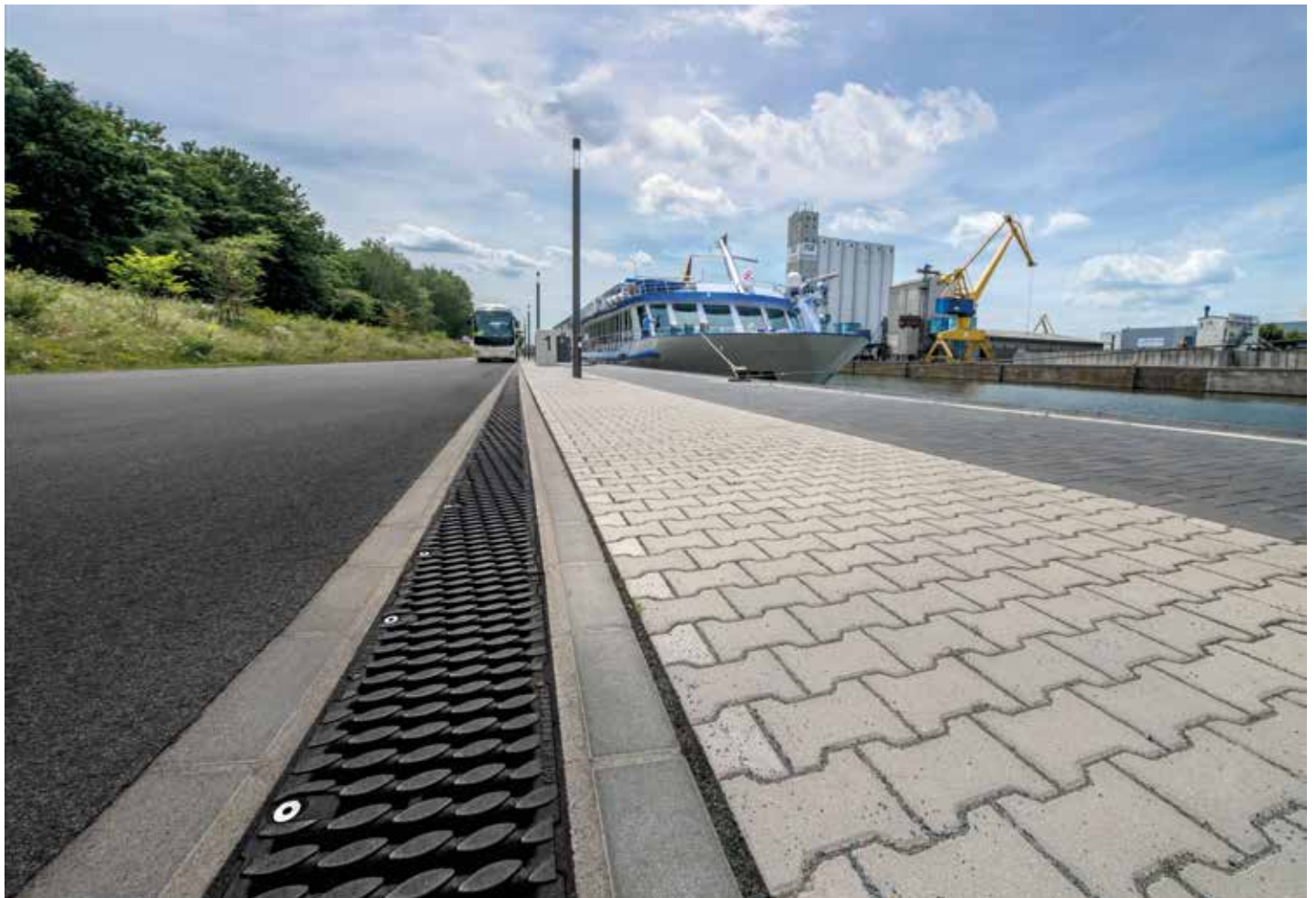
Schwerlastrinnen im Personenschiffahrtshafen Nürnberg
