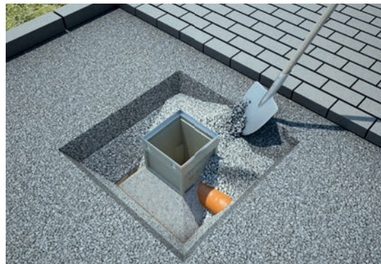
4. Grube mit Schotter auffüllen und sorgfältig verdichten.
