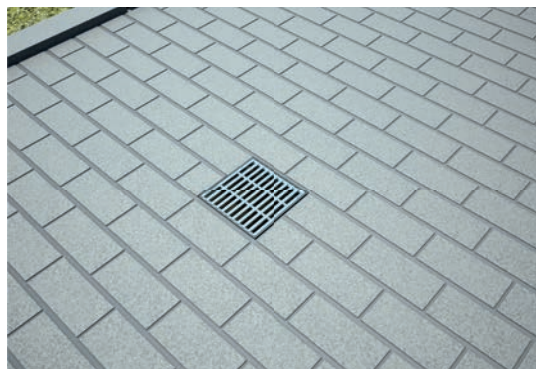
6. Pflaster verlegen. Der Belag sollte 2 bis 5 mm höher als der Abdeckrost abschließen.
