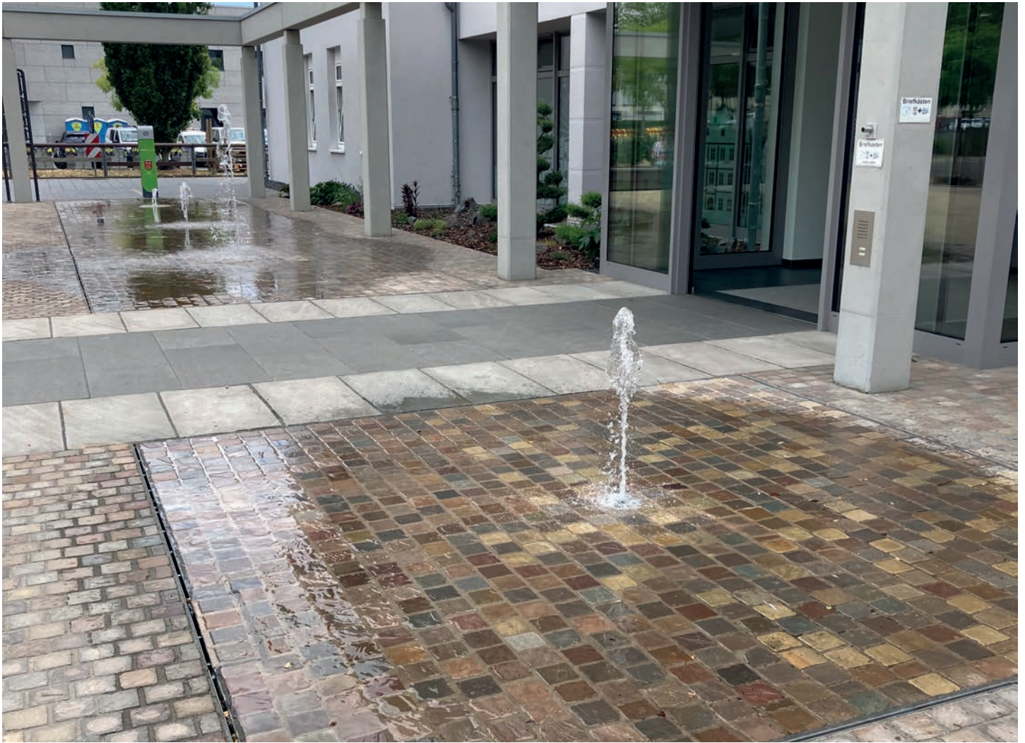
Caniveaux à fente sur la place devant l'hôtel de ville de Wittlich
