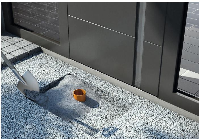
1. Grube für Schuhabstreifkasten ausheben, Splitt- oder Ortbetonbett einfüllen und sofern vorgesehen, Anschlussrohr heranführen
