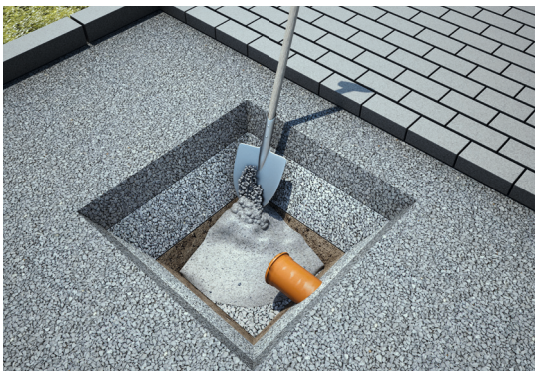
1. Rohrleitung zum Hofeinlauf richten. Baugrube ausheben und Betonbett gemischt aus 3 Teilen Sand + 1 Teil Zement + 1 Teil Wasser einfüllen.
